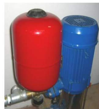
Rys. 10: Zbiornik membranowy (zalecany)
