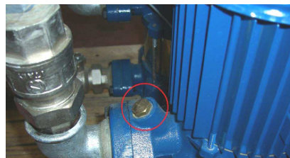
Rys. 6: instalowanie transduktora do odpowietrzania przy wylocie pompy
