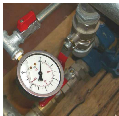
Rys.4 : Manometr, który może być zastąpiony poprzez przetwornik
